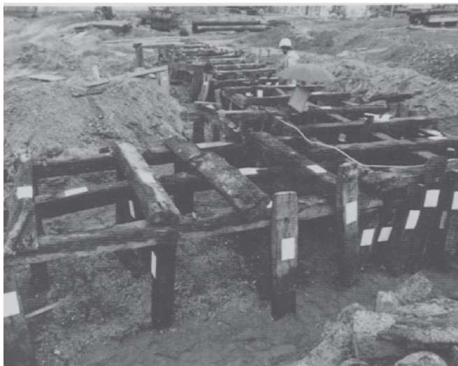
Holzrost-Gründung unter der Hafenbastion, 1994
